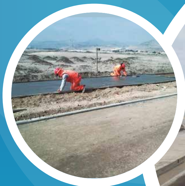
Pavimentación y señalización Av. San Pedro
